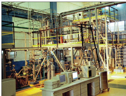
Instalație pilot experimentală pentru separarea tritiului și deuteriului – obiectiv de interes național, cu misiunea de a dezvolta tehnologia de detritiere a apei grele utilizată ca moderator la reactoarele nucleare CANDU și de a verifica materialele și echipamentele specifice în mediul tritiat și la temperaturi criogenice
